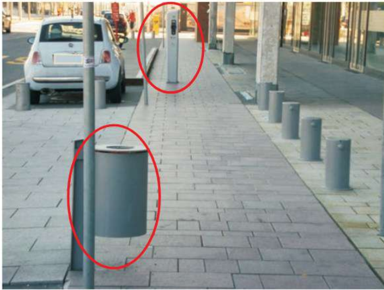
Deficiențe ce trebuie eliminate in faza de proiectare
